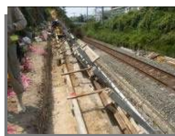
JR法面・土工一式
